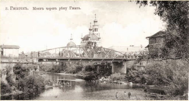
Гжатск. Мост через реку Гжать (начало XX века)
